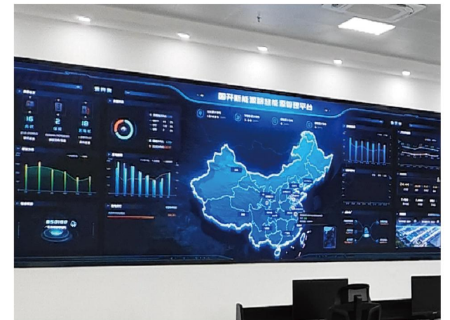
宿迁国开新能源 智慧管理平台项目
