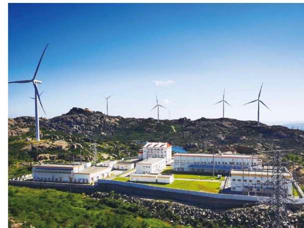
福能新能源公司岩前集控中心 升级改造项目
